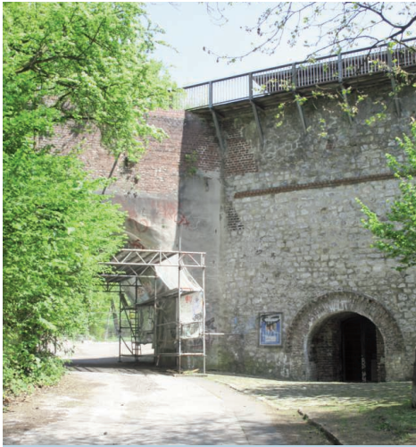
Das Viadukt zum Kalktrichterofen ist seit 2014 eingerüstet.
