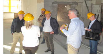
Seite: 6 Postboutique Hotel - Baustellenbesichtigung
