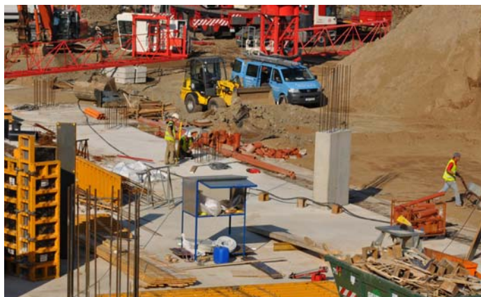
Baustelle Döppersberg. Bildquelle: Stadt Wuppertal.
