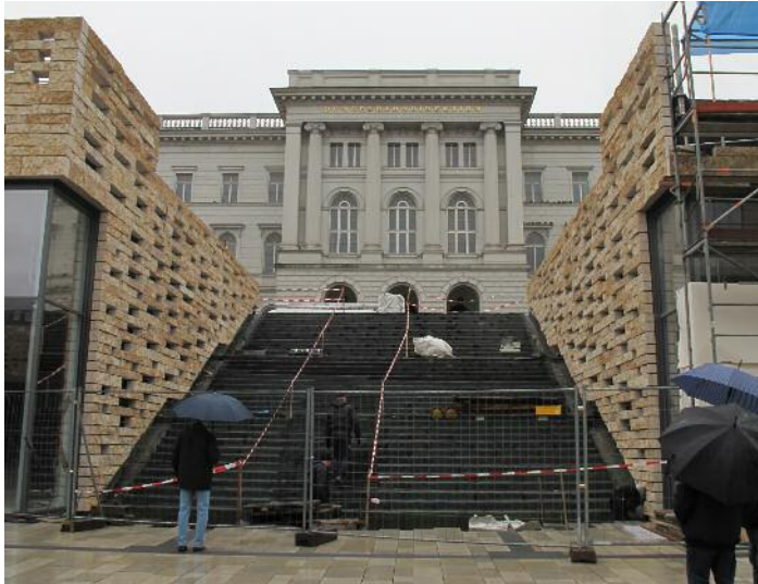
Neue Blickwinkel I.: Beeindruckende Perspektive auf das Gebäude der ehemaligen Bundesbahndirektion.
