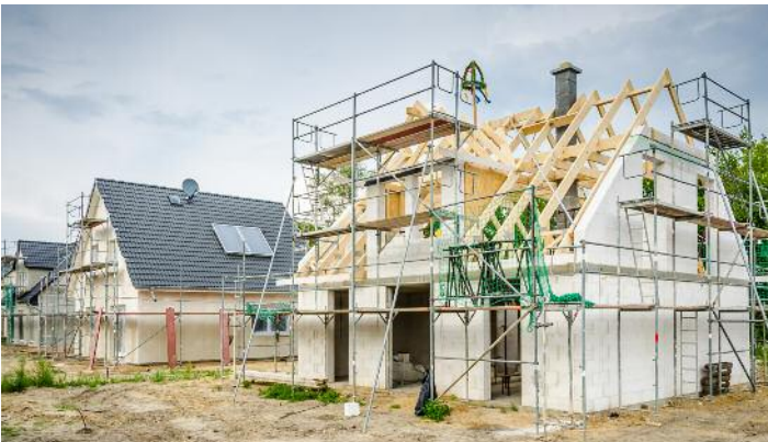
Baustelle einer Neubausiedlung.
